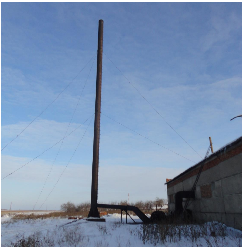
Рисунок 1.6 – Дымовая труба котельной с. Зюзя
