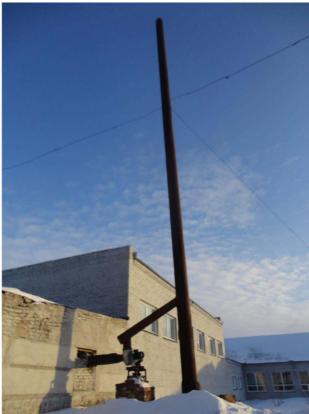
Рисунок 1.6 – Дымовая труба котельной д. Квашнино
