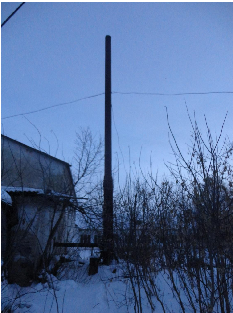
Рисунок 1.4 – Дымовая труба котельной д. Белово
